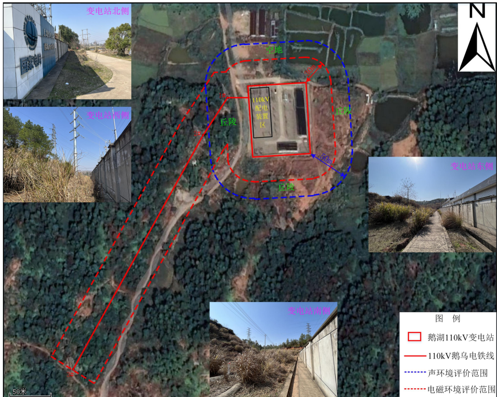
图 3-5 本项目变电站及输电线路周边环境现状图
