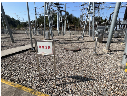
原有事故油池
