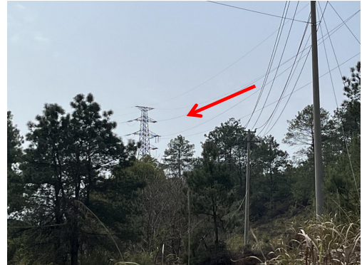
线路经过丘陵走线现状
