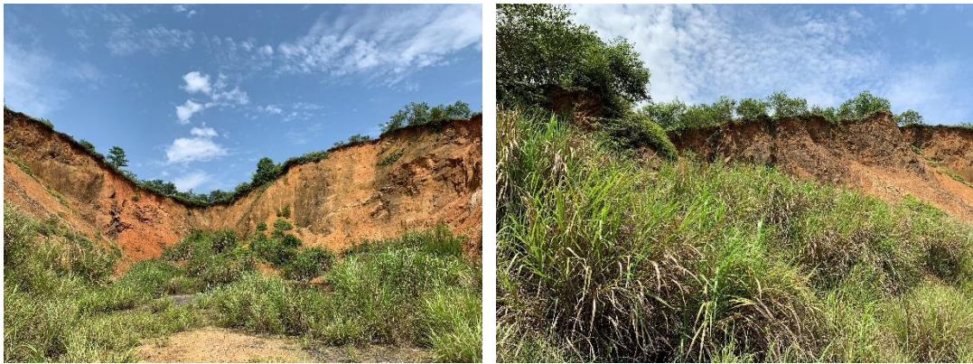
图 2-1 站址现场照片
