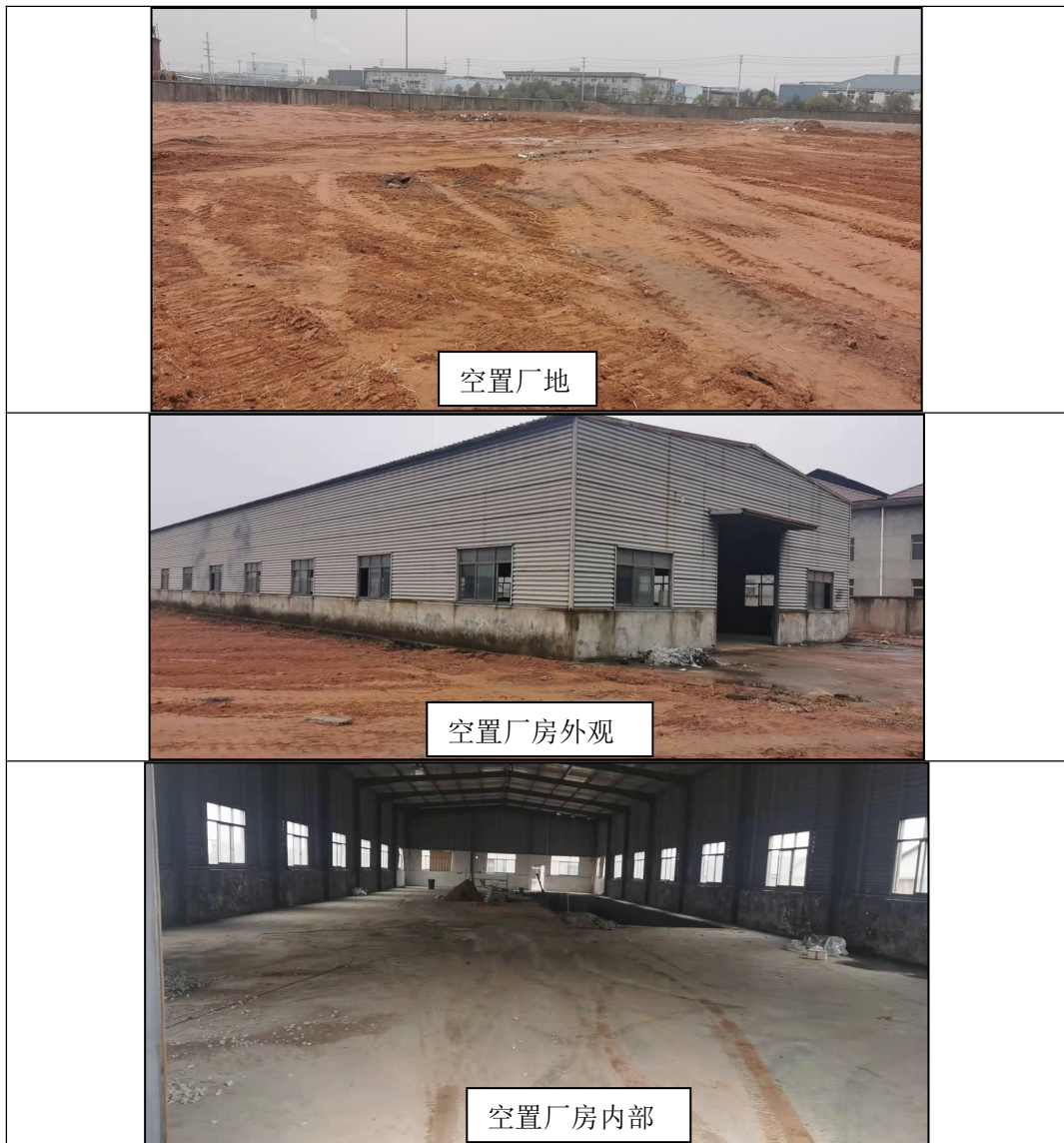
图 2-2 项目现场踏勘情况
