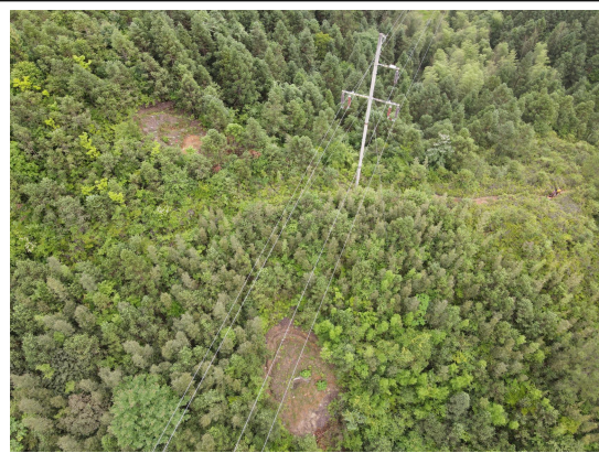
生态红线内塔基生态恢复照片
