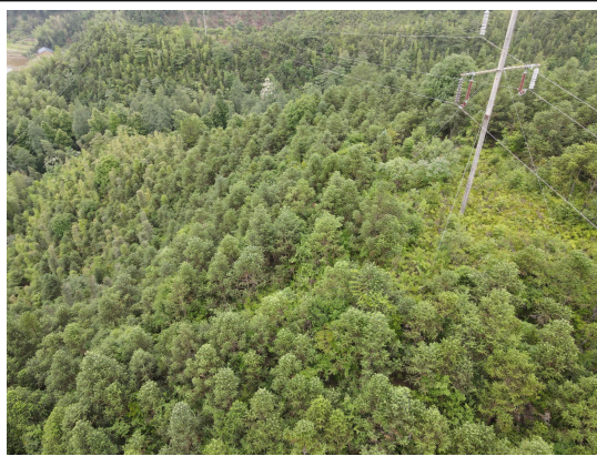
生态红线内塔基生态恢复照片
