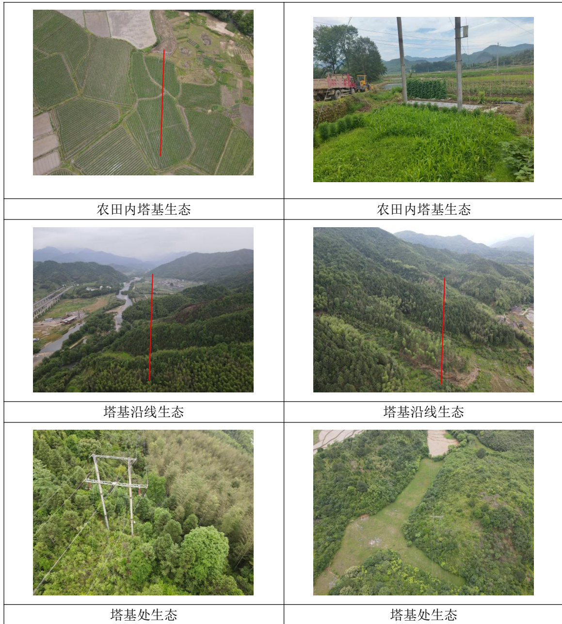
图 3-3 输电线路塔基处生态现状
