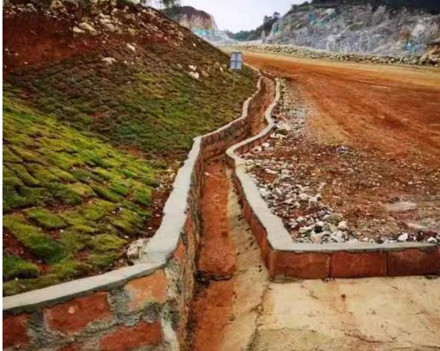
图 1-6 矿山截排水沟修建及上方土坡边坡绿化图
