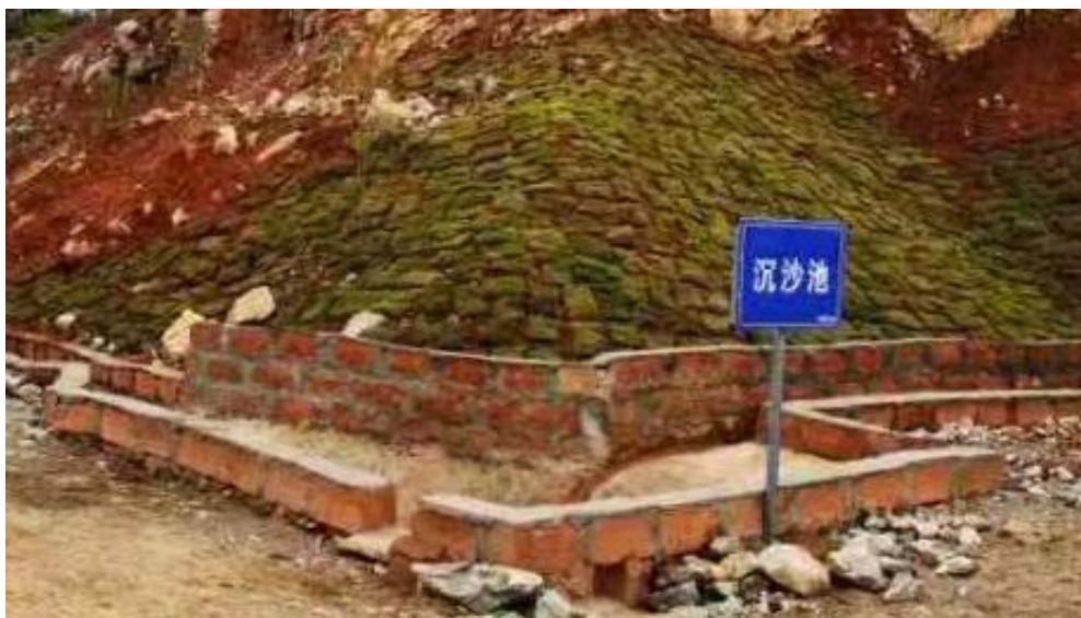
图 1-7 矿山修建沉淀池
