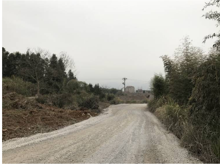
照片3 矿区道路(局部)
